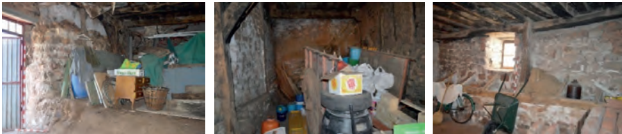
Restos de muralla en el interior del nº 9D y 1 de C/ San Isidro, junto con al nº 3 de Paz Villorobe
