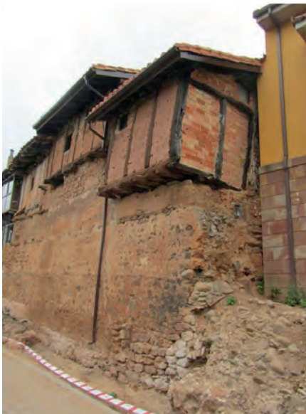
En esta zona es donde mejor se observan las diferentes partes de la muralla en esta fase (ss. XIV-XV)
