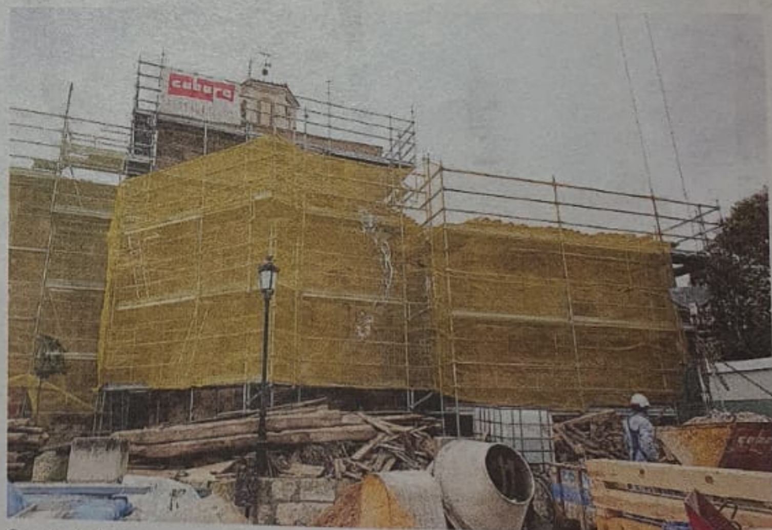
Se pretende recuperar el alero original románico del ala sur de la iglesia.
