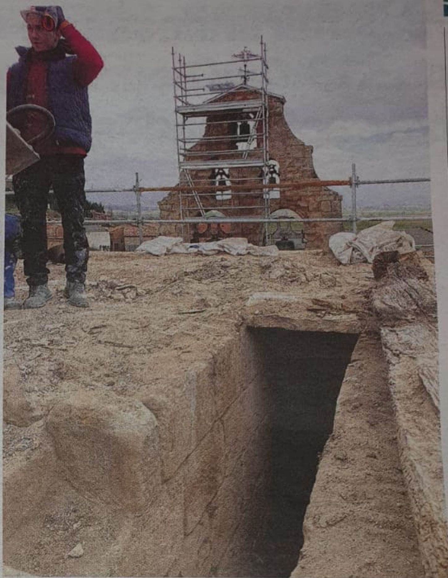
Han comprobado que las escaleras del coro dan a una de las cubiertas. / FOTOS: S.F.L.
